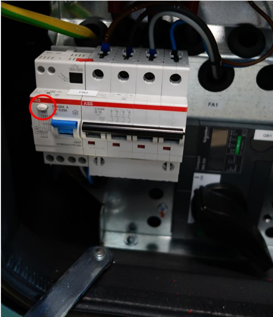
Abbildung 77: Funktionsprüfung des Fehlerstrom-Schutzschalters
